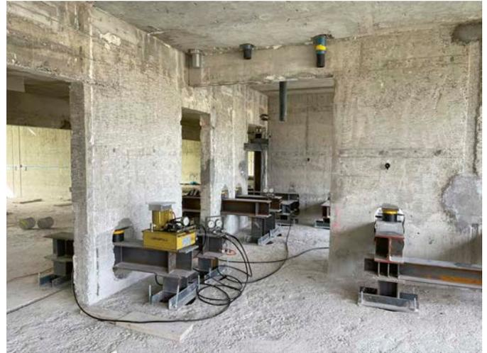
**Bild 8** Notsprößung mit hydraulischen Pressen (Quelle: Dr. Lüchinger+Meyer Bauingenieure)
