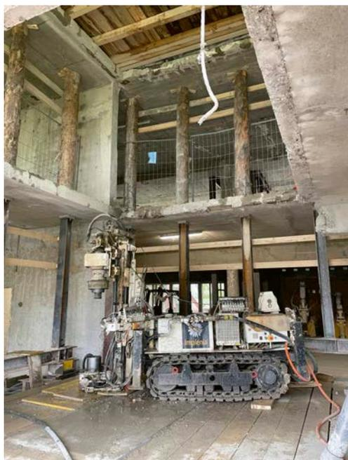
**Bild 10** Mikropfahlbohrgerät Treppenhaus, Bohrplanum auf Plattform im EG (Quelle: Dr. Lüchinger+Meyer Bauingenieure)
