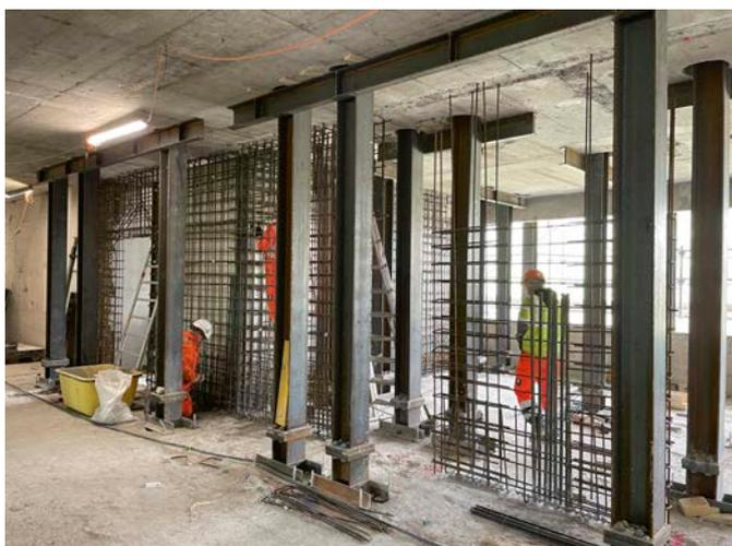
**Bild 12** Ausführung Abfangscheiben über Foyer (Quelle: Dr. Lüchinger+Meyer Bauingenieure)
