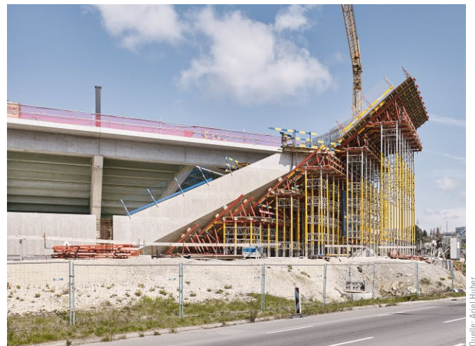
Bild 4 Ausführung der geneigten Eckscheiben Execution of the corner slabs
