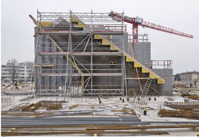
Bild 7 Ausführung der vertikalen Ortbetonwandscheibe der Tribünen Execution of the vertical concrete wall of the grandstands
