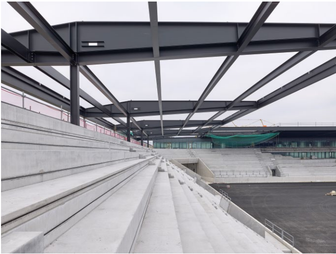
Bild 12 Ausführung der Stahlkonstruktion des Dachtragwerks Execution of the steelwork of the roof structure
