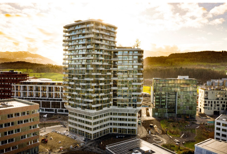
Aglaya – Wohnturm Suurstoffi, Rotkreuz (Foto: S+B Baumanagement)
