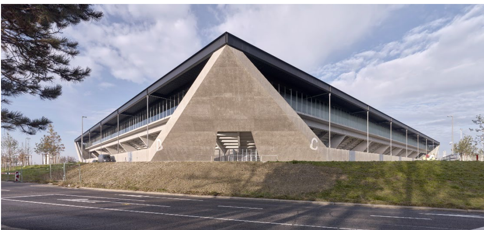
Stade de la Tuilière, Lausanne (Photo: Ariel Huber)
