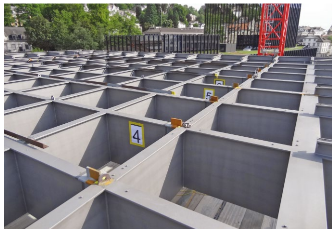
Bild 6 Trägerrost während der Montage Steel grid during the installation process
