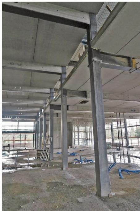
*Bild 8. Durchlaufträger mit Höhenversatz
