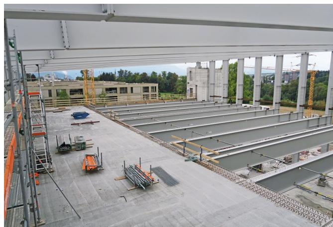
Bild 4. Verbunddecke der Sporthalle mit Filigranplatten
