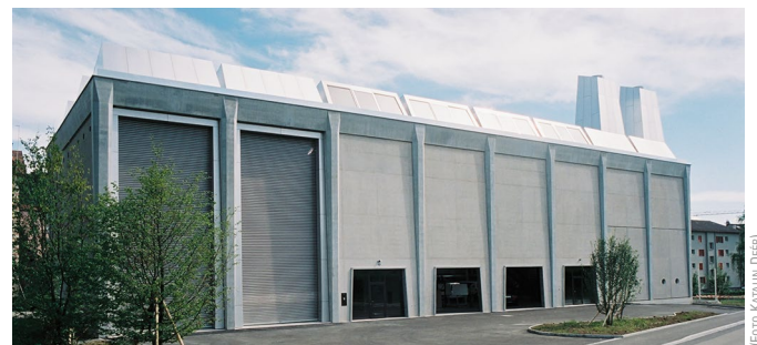
Bild 1 Fernwärmezentrale Waldau, St.Gallen (CH) Control center Waldau of the district heating network, St. Gallen
