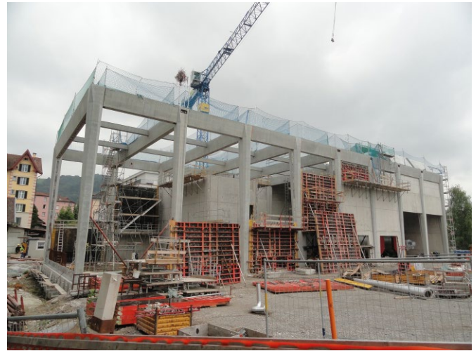
Bild 11 Erstellung der Ausfachungen Pooing the concrete infills
