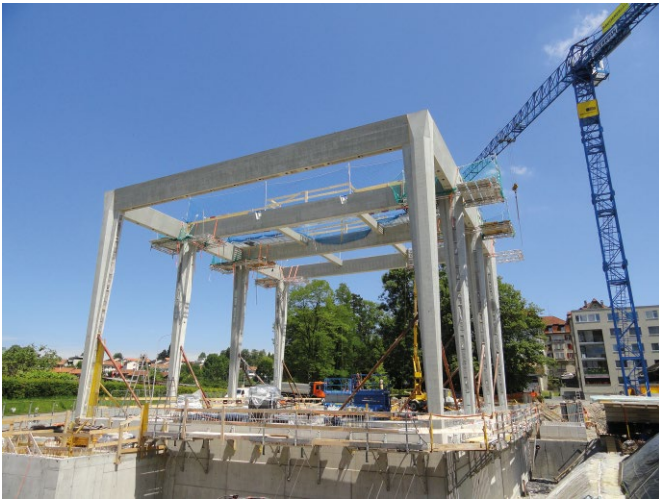
Bild 10 Aufrichten des Betonrahmentragwerks Erecting the concrete framework
