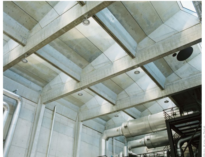
Bild 4 Innenansicht des Dachtragwerks Interior view of the roof structure
