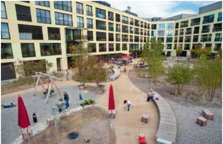
Aufbau Hof: Ansaat Ruderalflora, Substrat Kies/Humus (Anteil 90/10, Höhe 20cm); Wandkies als Ausgleichsschicht (Höhe 5-37cm)
